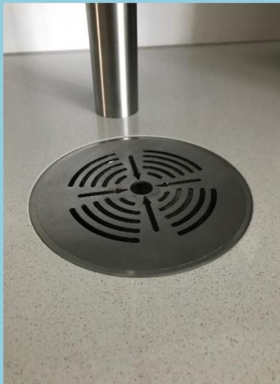
Bündig eingelassen und eingeklebt.
